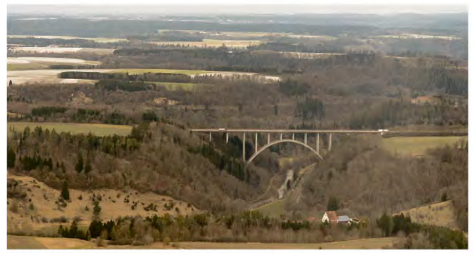
Wie ein Ausschnitt aus einer Eisenbahnlandschaft wirkt das große Eisenbahnviadukt von oben.
